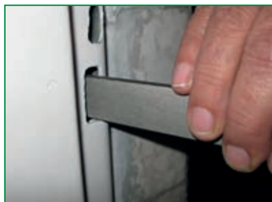
شکل ۱-۴- سوهان کاری سوراخ چهارچوب درب
