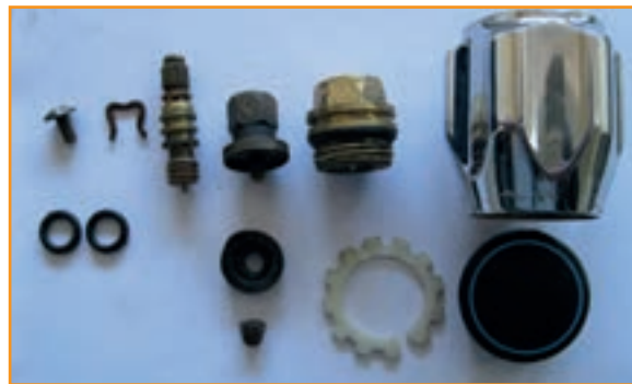
شکل ۲-۸- پیاده کردن قطعات شیر آب
