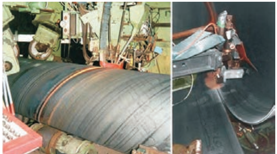
شکل ۴-۲۵-ب جوشکاری خارج لوله
