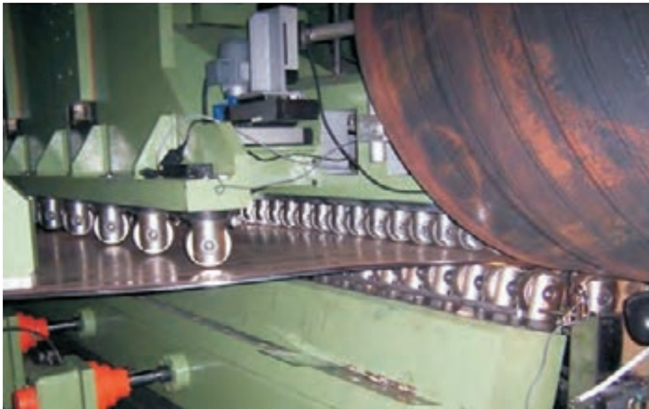
شکل ۴-۲۳-ج شکل دهی لوله‌ها
