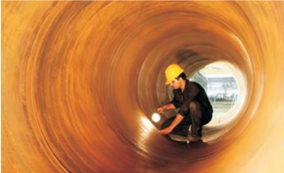
شکل ۴-۲۹ بازرسی چشمی لوله‌ها
