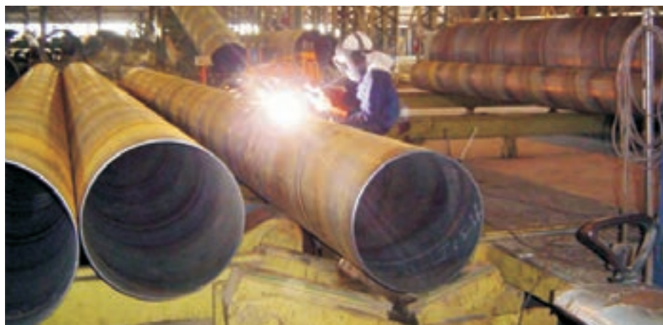
شکل ۴-۳۱ تعمیر لوله‌های معیوب
