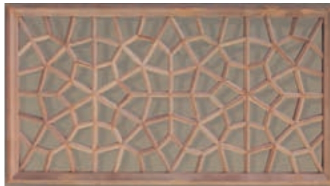
شکل ۹-۸۸- اتصال متقاطع در گره چینی یک پنجره.
