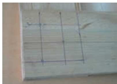
شکل ۵-۷۳- طریقه میخ‌کاری با فاصله مناسب
