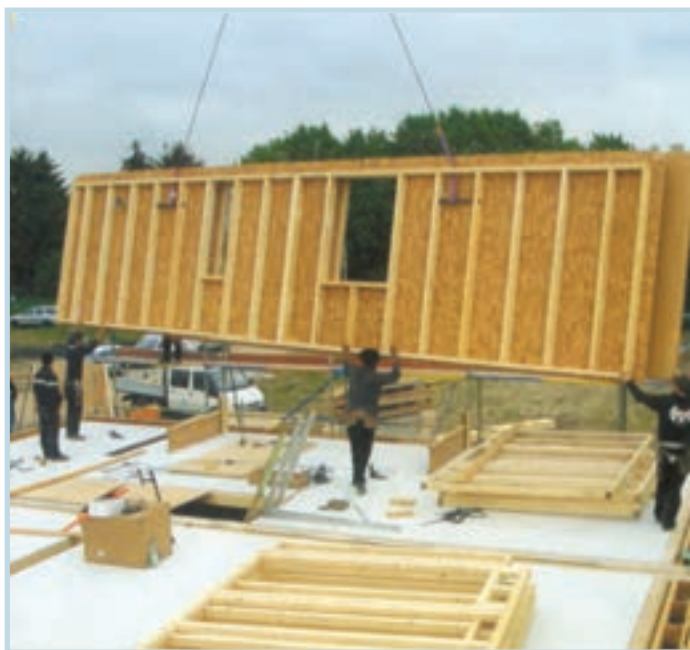
شکل ۳-۱- سوار کردن قطعات پیش ساخته در ساختمان
