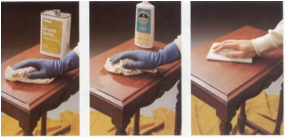
شکل ۱۲-۵- واکس زدن با پارچه
