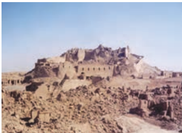
(ب) ارگ بم بعد از زلزله
