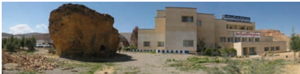
شکل ۵-۵- مجتمع آبگرم محلات
