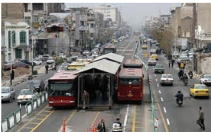
شکل ۲۹-۱- ایستگاه اتوبوس‌های تندرو (BRT)
