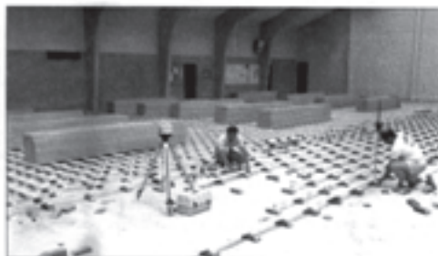
شکل ۳-۵ طرح نصب نصب پارکت
