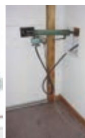
شکل ۴-۲ سیستم‌های در اتوماتیک پنوماتیکی
