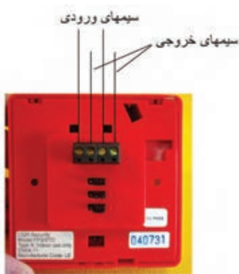
شکل ۳۹-۱ سیمهای اتصال شستی
