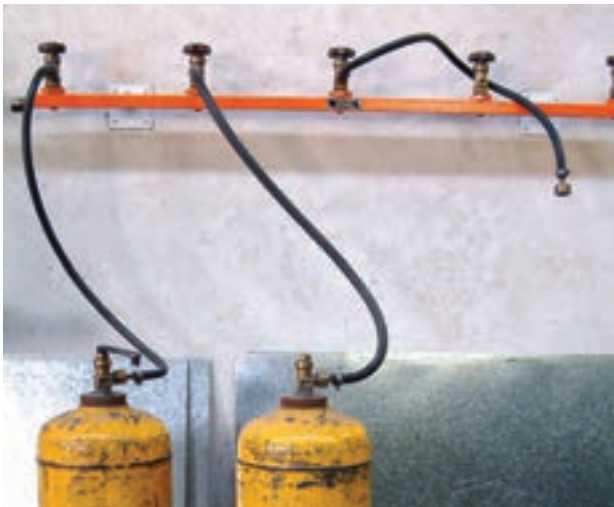
شکل ۲-۲۵- گاز استیلین از کپسول به خط لوله‌ی گاز هدایت می‌شود.
