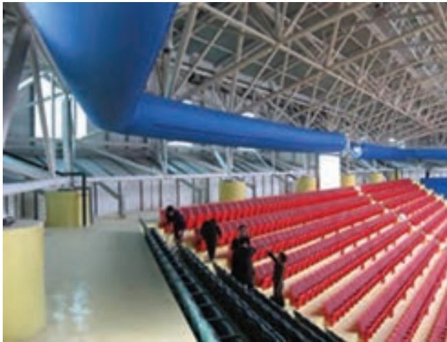
شکل ۴-۶- کانال‌های ورود و خروج با سقف‌های متفاوت
