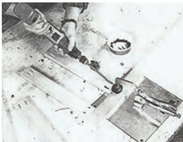
شکل (۵-۲۰) اتصال پیچ تحت زاویه به وسیله شابلون مخصوص
