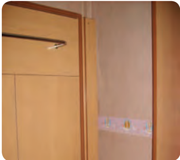
شکل ۵-۱۲۴- نصب مانع پشت در قبل از نصب سقف کمد لباس
