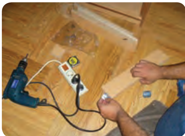
شکل ۱۷۹-۵- آماده کردن پاسنگ‌ها
