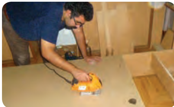
شکل ۵-۱۶۲- نصب فیبر پشت‌بند و در آوردن جای عبور سیم برق روی آن
