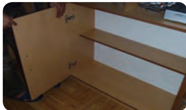
شکل ۵-۱۶۴- نصب در کمد زیر جای تلویزیون
