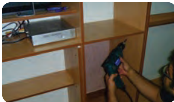
شکل ۱۷۲-۵- نصب صفحه میز آرایش
