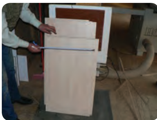
شکل ۱۱۶-۵- کنترل اندازه قطعات آماده شده
