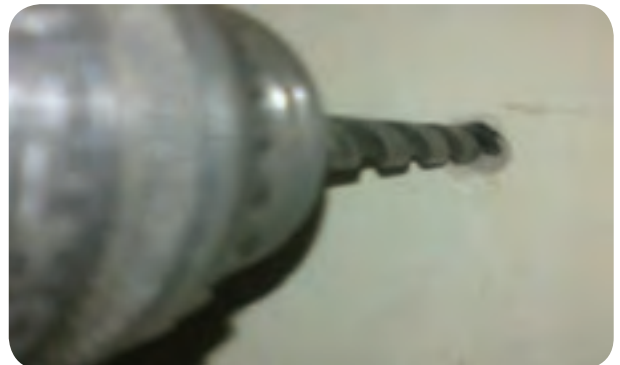
شکل ۶-۶ - سوراخکاری دیوار با مته الماسه مناسب
