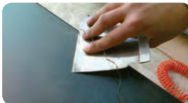
شکل ۲۵-۴ - نحوه برطرف کردن اضافه نوار با لیسسه
