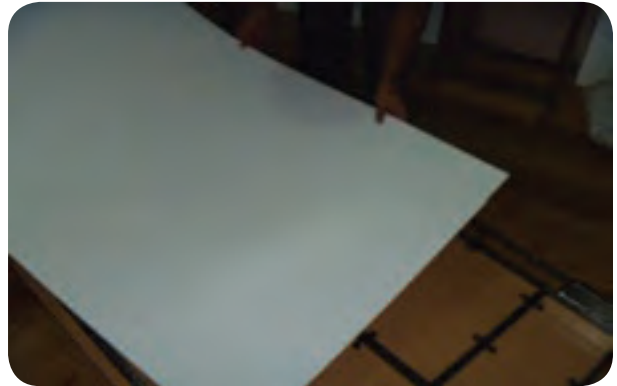
شکل ۵-۱۳۴ نصب ورق فیبر در کف کلاف فلزی (زیر تشک)
