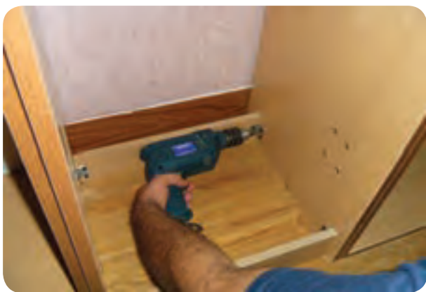
شکل ۱۸۰-۵- نصب پاسنگ‌ها
