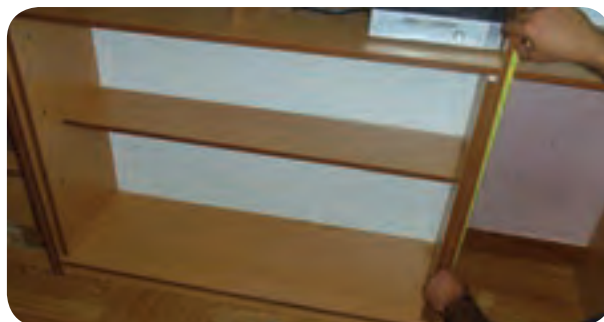
شکل ۱۷۳-۵- اندازه‌گیری برای نصب صفحه زیر کشوها
