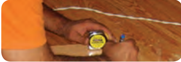
شکل ۵-۱۲۳- علامت‌گذاری و تعیین محل سوراخ‌ها
