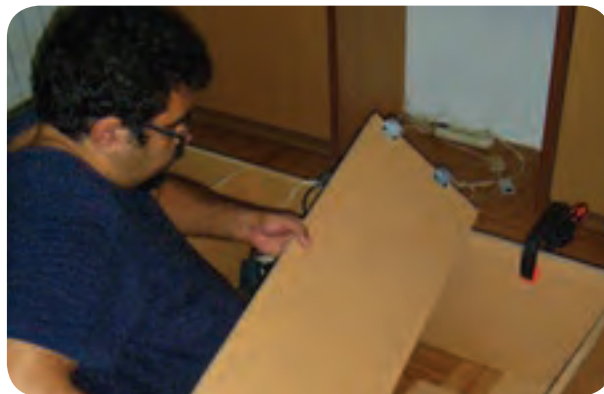
شکل ۵-۱۶۱- نصب طبقات به وسیله گونیاها فلزی
