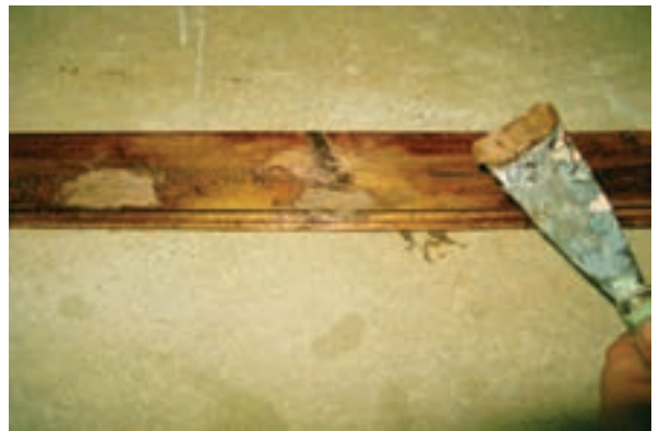
شکل ۴۱-۶- رنگ بتونه بایستی با قسمت آستر خورده هم‌رنگ باشد.
