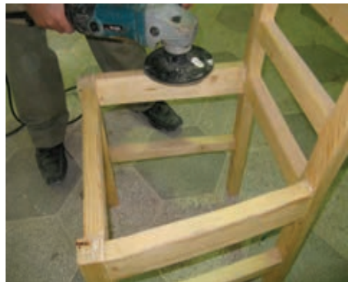
شکل ۳۷-۶- پرداخت کاری قبل از بتونه.
