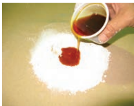
شکل ۲۵-۶- اضافه نمودن رنگ روغنی به بتونه روغنی.
