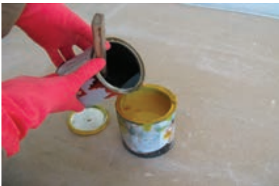
شکل ۲۹-۱۲- اضافه کردن روغن جلا برای براقیت بیشتر رنگ روغنی.
