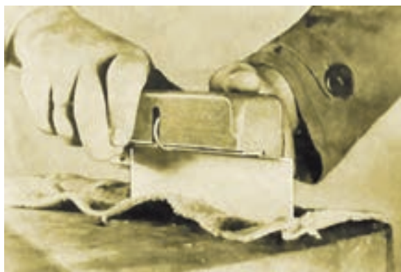
شکل ۳-۴۵- مصقل‌کشی نر لیس با رنده مصقل.
