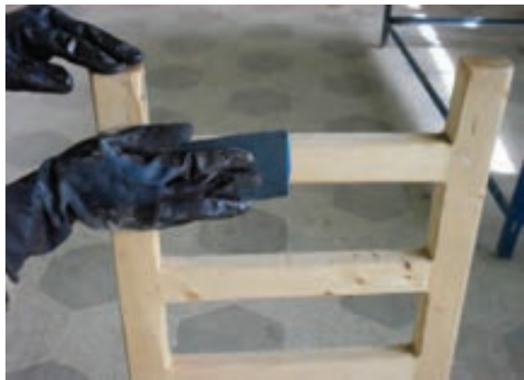
شکل ۶-۱۲- پوست آب کاری روی سطح سیلر فورده.
