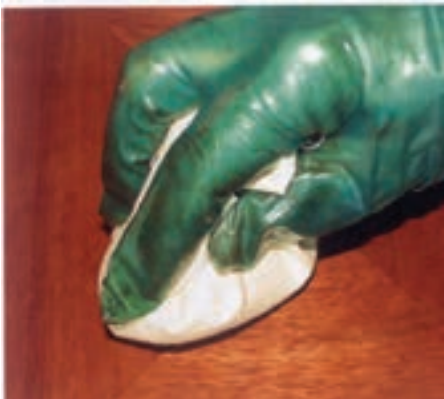
شکل ۵-۸- زدن سیلر با کهنه رنگ‌کاری.
