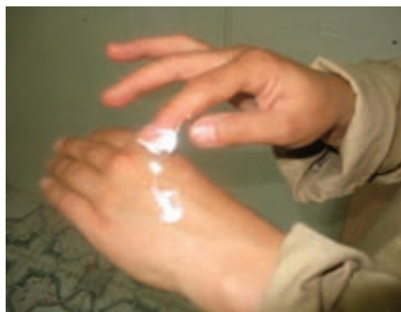
شکل ۱۴-۱۱- استفاده از کرم قبل از رنگ‌کاری پوششی.
