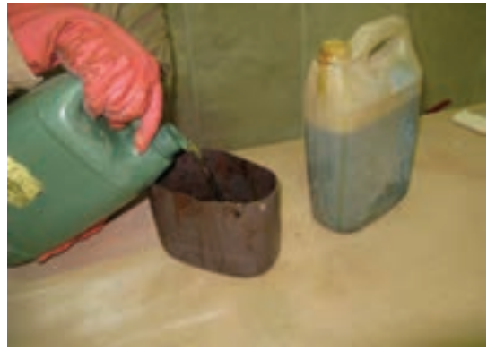
شکل ۸-۱۰- رقیق کردن روغن الیف با تینر روغنی.
