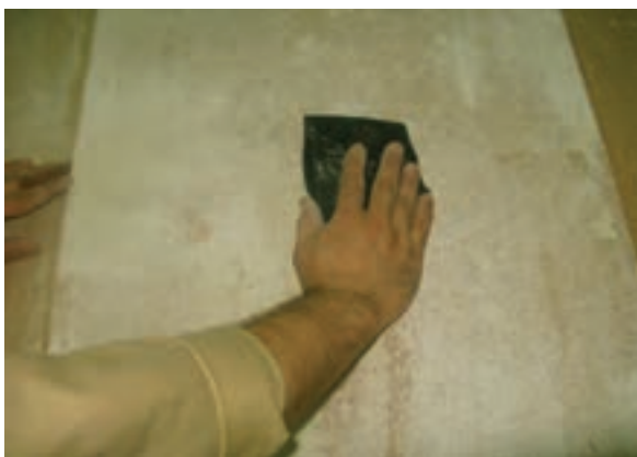
شکل ۴۹-۶- سنباده‌کاری (روی سطح بتونه سریشی).
