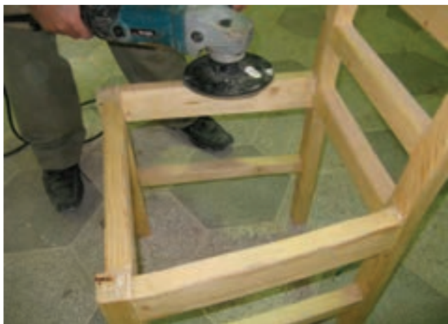
شکل ۴۸-۱۲- پرداخت کاری سطح کار با استفاده از ماشین پوست گرد (دیسکی).
