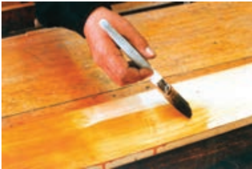
شکل ۳۴-۸- سیلرکاری در جهت الیاف.
