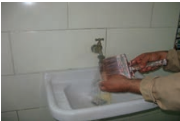
شکل ۵۷-۱۳- شستن قلم‌موی ساختمانی با آب.
