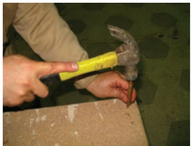
شکل ۱۷-۱۱- سنبه کردن میخ در یک کار پوششی.
