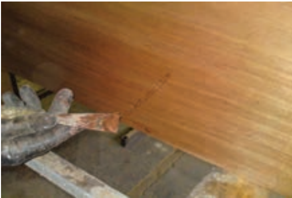
شکل ۴۲-۶- ابتدا ترک‌ها را بتونه نمایید.
