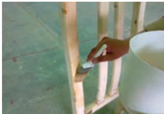
شکل ۴۷-۱۲- زدن آب روی گره قبل از آستری زدن.
