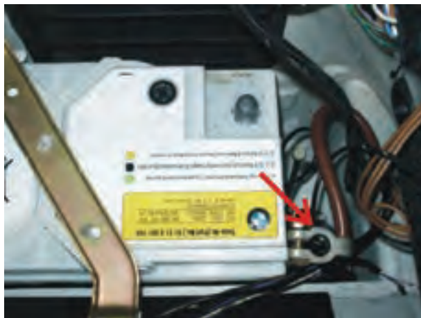
شکل ۳۵-۱- جدا کردن بست اتصال کابل بدنه‌ی باتری
