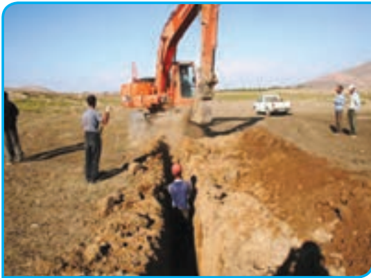
کندن زمین با بیل مکانیکی
