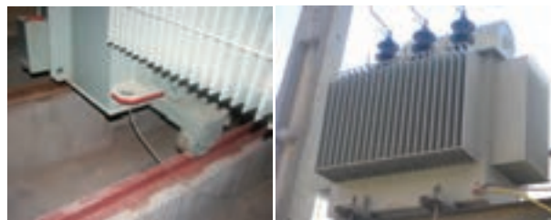
شکل ۳۳- محل اتصال سیم زمین
