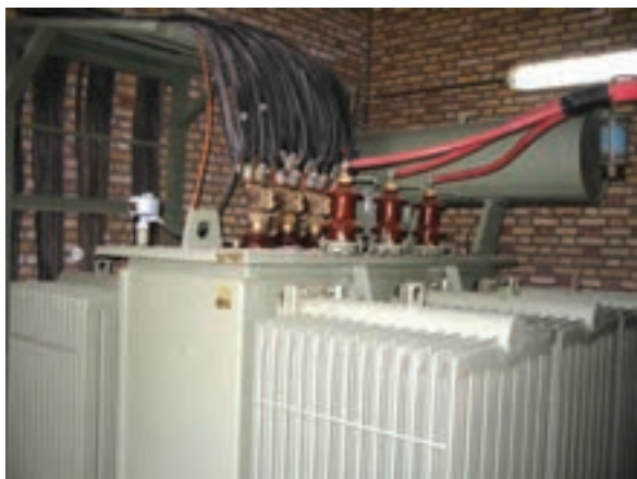
ب) ترانسفورماتور بدون جعبه ترمینال
