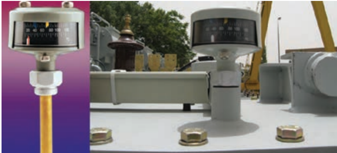
شکل ۲۲- ترمومتر ساده کنتاکت دار و محل نصب آن روی مخزن ترانسفورماتور
