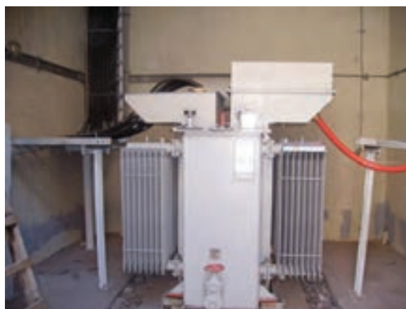
الف) ترانسفورماتور با جعبه ترمینال
