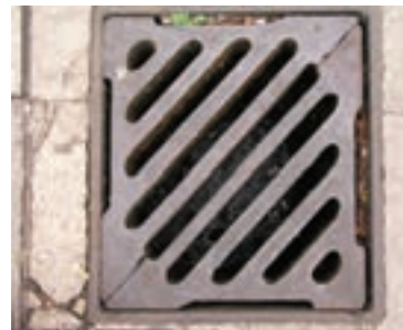
شکل ۱۰-۲ درب چاه های شهری از چدن
