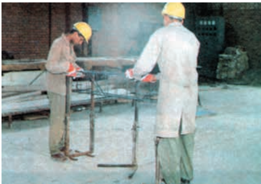
شکل ۱۲-۳- طریقه‌ی مونتاژ آرماتورهای یک پوتر کوچک
