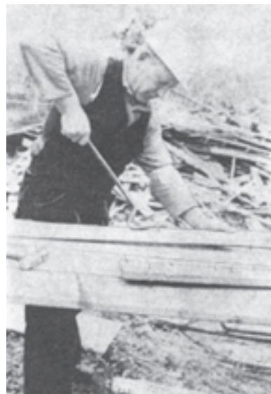
شکل ۱-۳۰ - میخ‌کشی از تخته توسط میخ‌کش اهرمی
