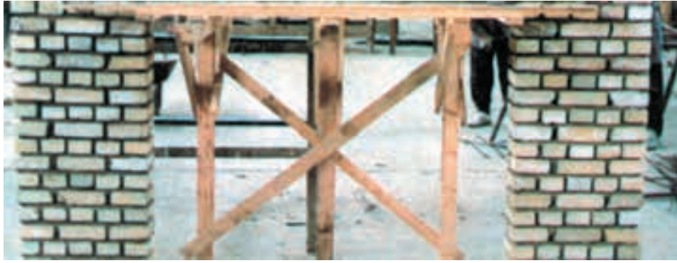
شکل ۱۰-۳- صفحه‌ی قالب و چپ و راست
