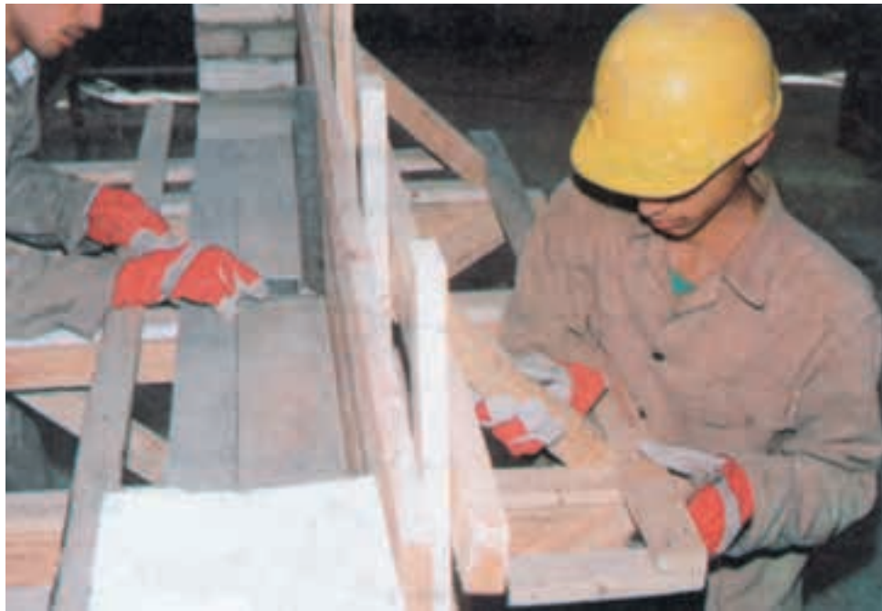
شکل ۱۱-۳- نصب گونه، گونیاکردن و نصب دستک‌ها
