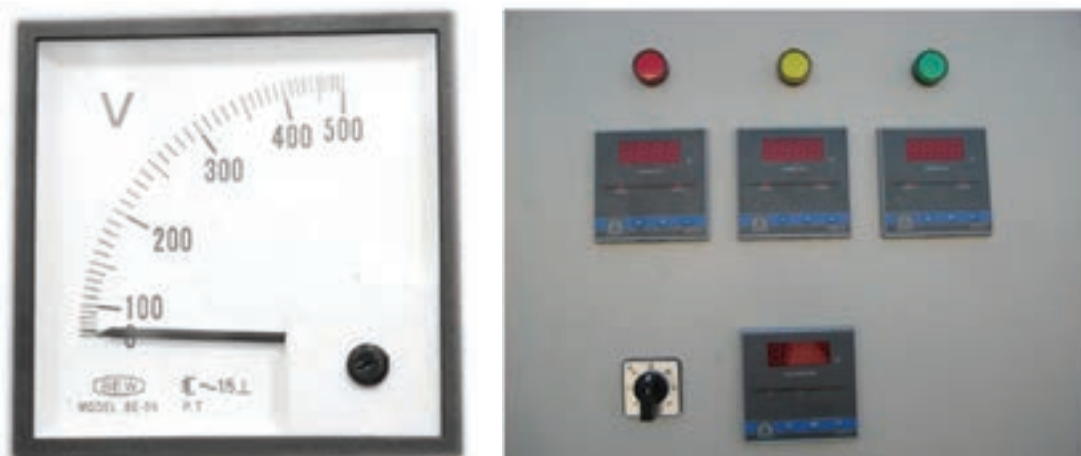
شکل ۹-۱۱- نمونه ولت متر تابلویی
