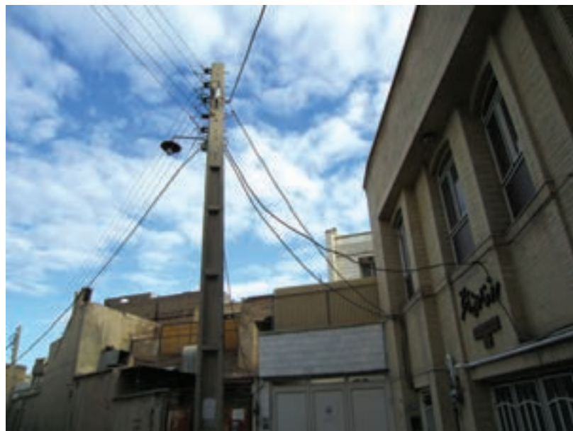
شکل ۱-۹ چگونگی اتصال برق منازل مسکونی.
