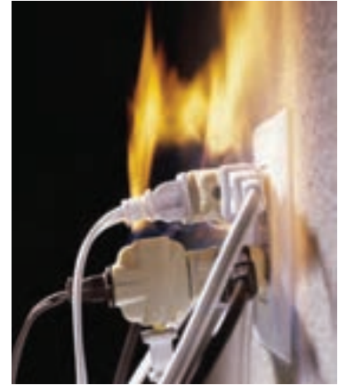
شکل ۲-۱ آتش‌سوزی حاصل از ایجاد جرقه و سوختن سیم‌های برق.
