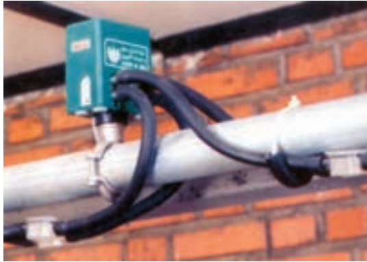
شکل ۴۰-۴ — دستگاه نبض‌ساز
