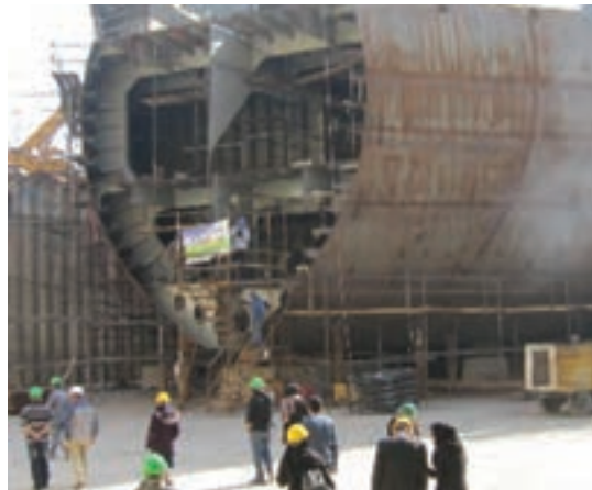
کشتی در حال ساخت
