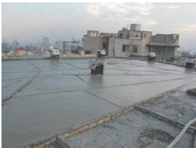
شکل ۵-۱۵ ▲ پر کردن فاصله بین شمشه‌های سیمانی با بتن سبک
