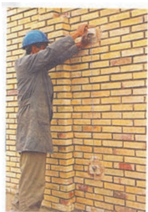
▲ شکل ۲۰-۳ شاقولی کردن کرم‌ها
