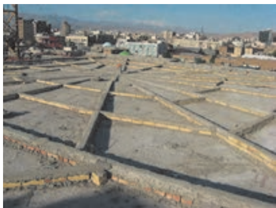
شکل ۵-۱۴ ▲ کرم‌بندی و شمشه‌گیری بین آن‌ها
