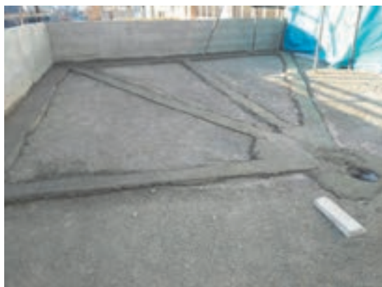
شکل ۵-۱۴ ▲ کرم‌بندی و شمشه‌گیری بین آن‌ها
