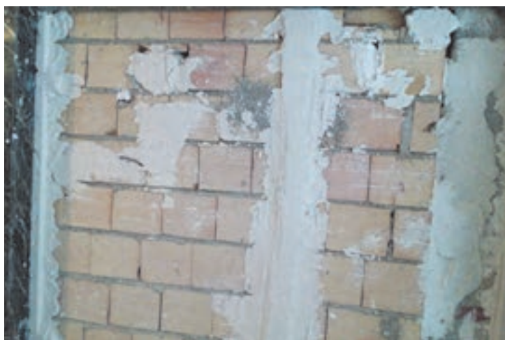
شکل ۳-۲۴ ▲ شمشه‌گیری بین کرم‌ها
