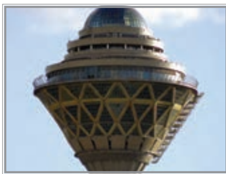
شکل ۱- سازه فلزی برج میلاد
