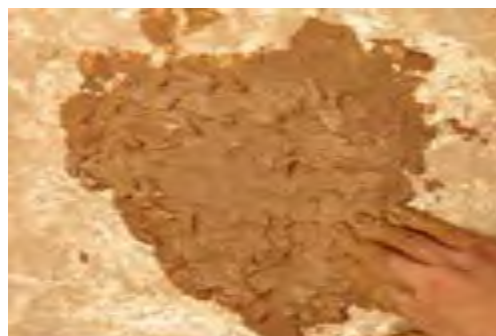
شکل ۱۱- تهیه گل یکنواخت با دوغاب
