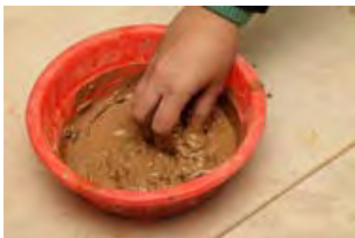
شکل ۱۱- تهیه گل یکنواخت با دوغاب
