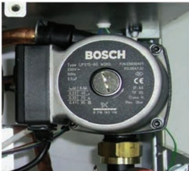
شکل ۱۴-۲۰ الکتروپمپ
