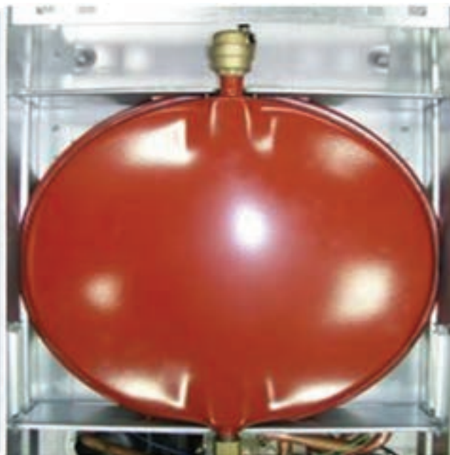
شکل ۲۲-۱۴- شیر هواگیری اتوماتیک
