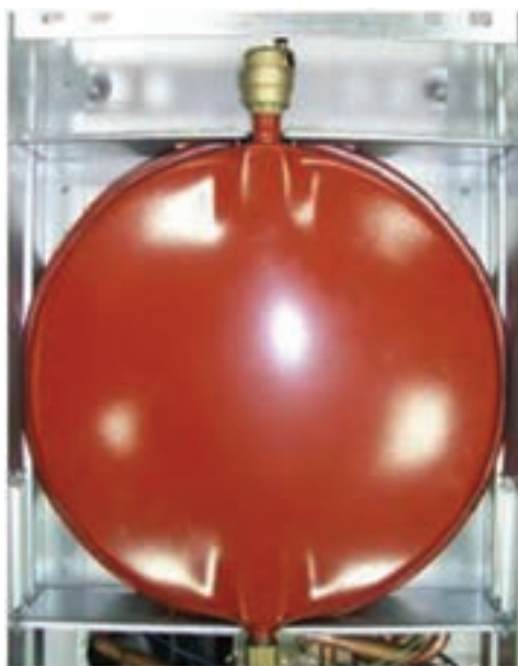
شکل ۱۴-۲۱ مخزن انبساط با شیر هواگیری
