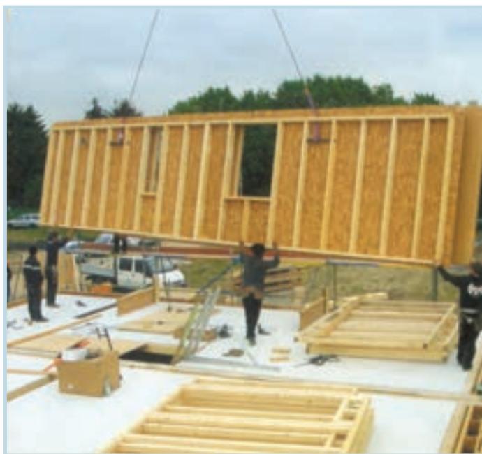
شکل ۳-۱- سوار کردن قطعات پیش ساخته در ساختمان
