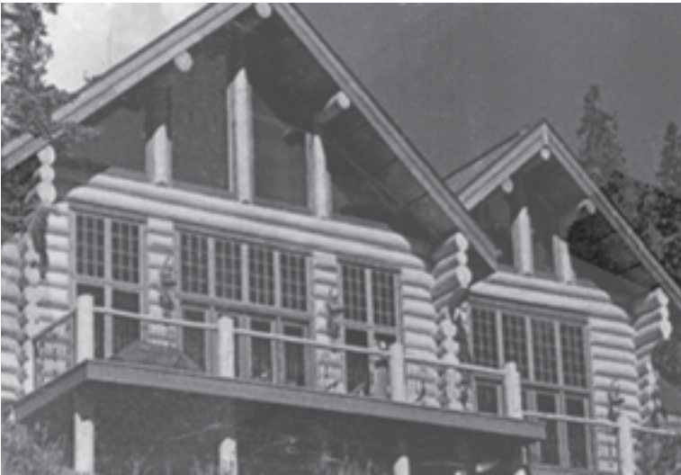
شکل ۲۹-۱- نمونه‌ای از ساختمان با چوب‌های گرد
