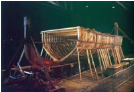
شکل ۱۵-۲- داربست اطراف اسکلت
