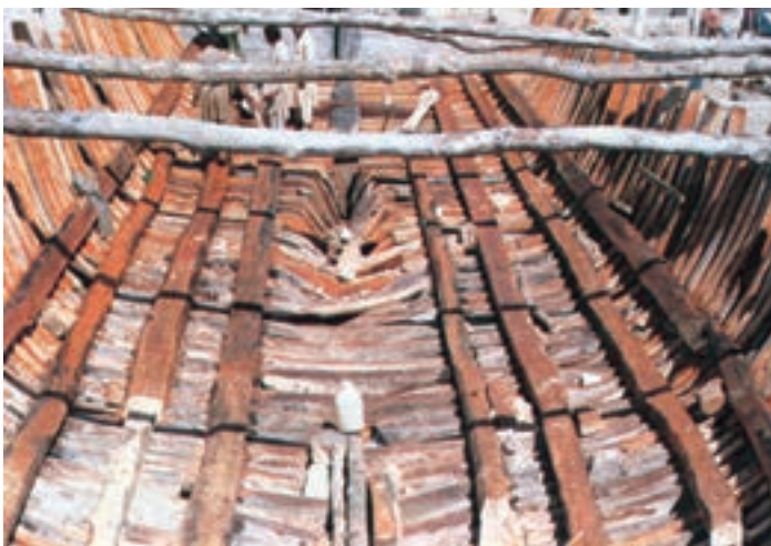
شکل ۱۳-۲- نصب تیرهای طولی روی فریم‌ها
