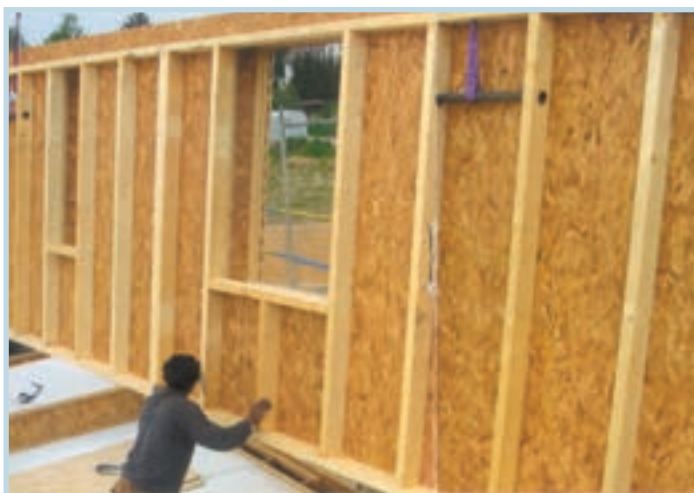
شکل ۴-۱- دیوار پیش ساخته چوبی در حین نصب
