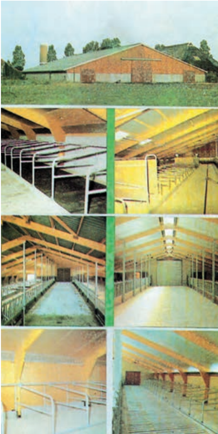
شکل ۱۷-۲ جایگاه و قسمتهای مختلف آن که طبق موازین فنی و بهداشتی احداث گردیده و به راحتی قابل ضدعفونی می باشد.
