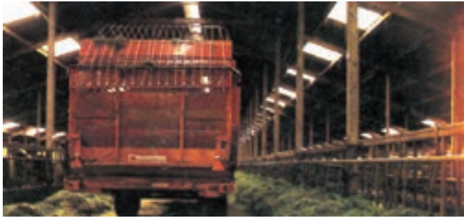
شکل ۶-۳ نمای پنجره‌های سقفی در اصطبل
