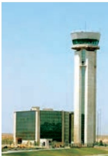
شکل ۱۱-۴- سازه بتن مسلح برج مراقبت فرودگاه بین‌المللی امام خمینی - تهران
