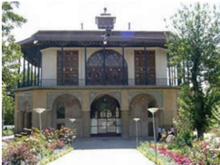
▲ شکل ۸-۱۲- عمارت چهلستون، قزوین
