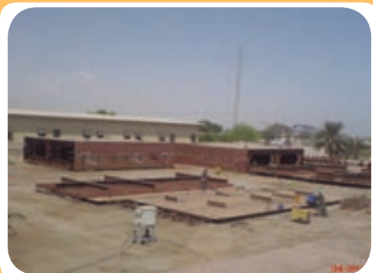
د) کارگاه ساخت اسکلت فلزی ساختمان
