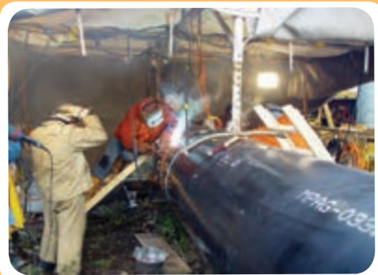
ن) کارگاه ساخت خط لوله
