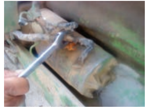
شکل ۵۰-۶- باز کردن کابل مثبت از استارت
