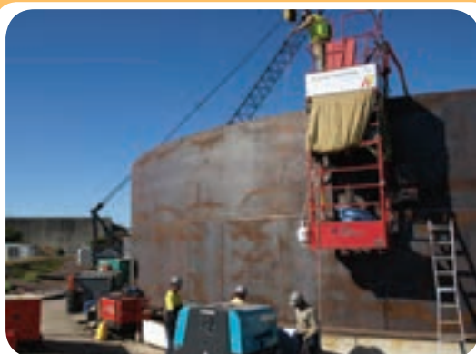
م) کارگاه ساخت مخازن ذخیره
