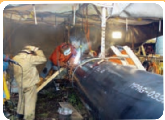
ن) کارگاه ساخت خط لوله
