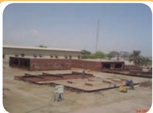
د) کارگاه ساخت اسکلت فلزی ساختمان
