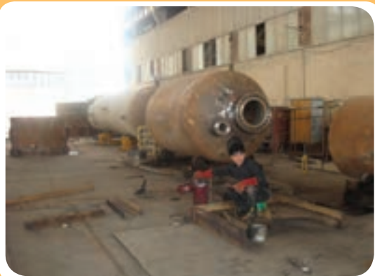
ب) کارگاه ساخت مخازن تحت فشار
