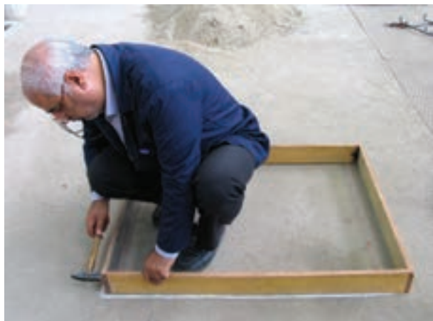
شکل ۳-۴- قالب بندی فونداسیون
