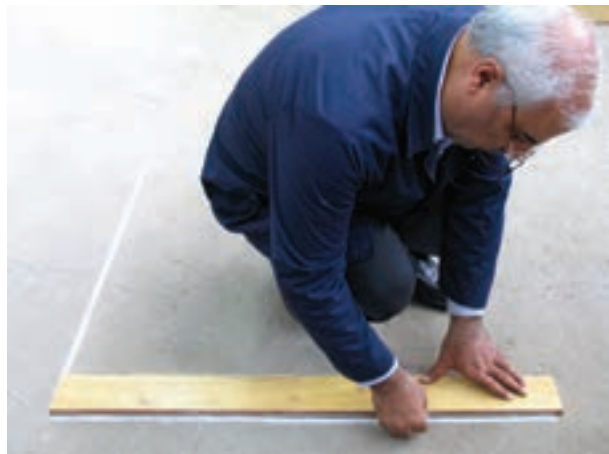
شکل ۳-۱- علامت گذاری فونداسیون
