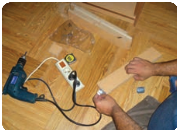
شکل ۱۷۹-۵- آماده کردن پاسنگ‌ها
