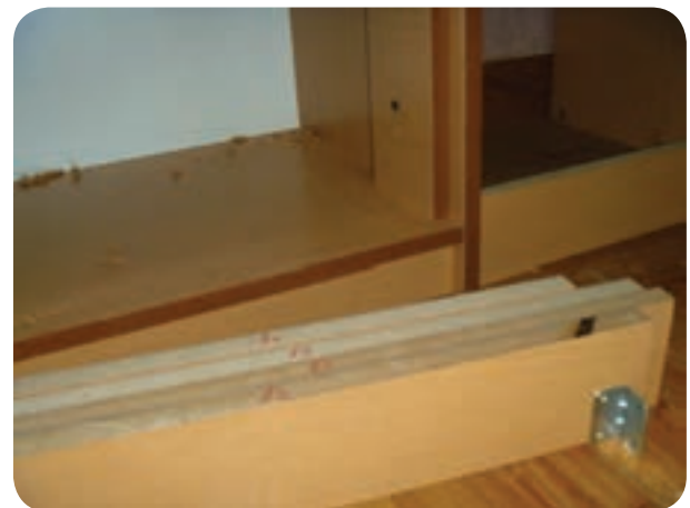
شکل ۱۶۶-۵- نصب پاسبنگ با استفاده از گونیای فلزی
