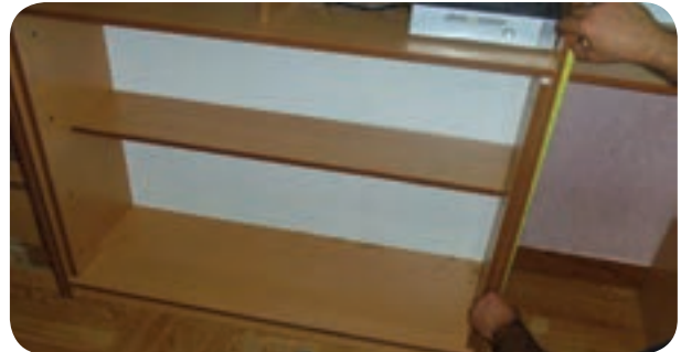
شکل ۱۷۳-۵- اندازه‌گیری برای نصب صفحه زیر کشوها
