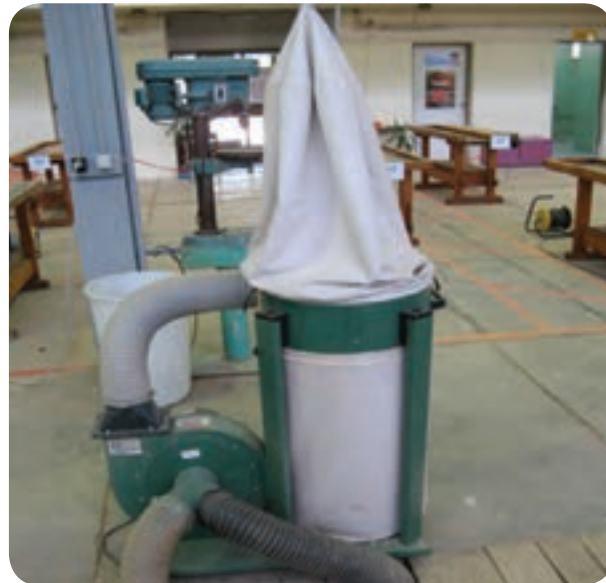
شکل ۵-۲۴- خروج ضایعات از طریق کانال پوشیده شده
