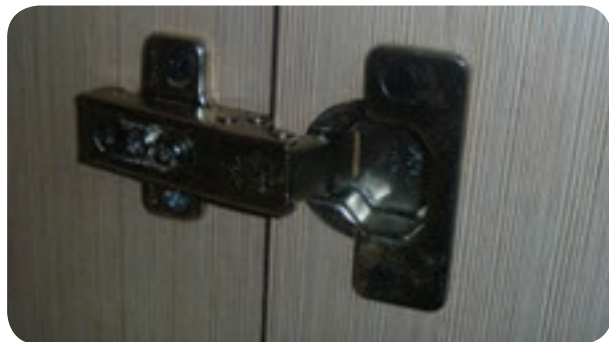
شکل ۵-۱۶۳- نصب لولای گازی فنردار به در کمد
