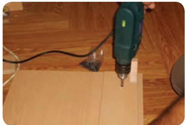
شکل ۱۴۶-۵- آماده‌سازی بدنه کمد لباس و نصب مانع
