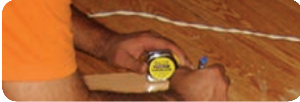
شکل ۵-۱۲۳- علامت‌گذاری و تعیین محل سوراخ‌ها
