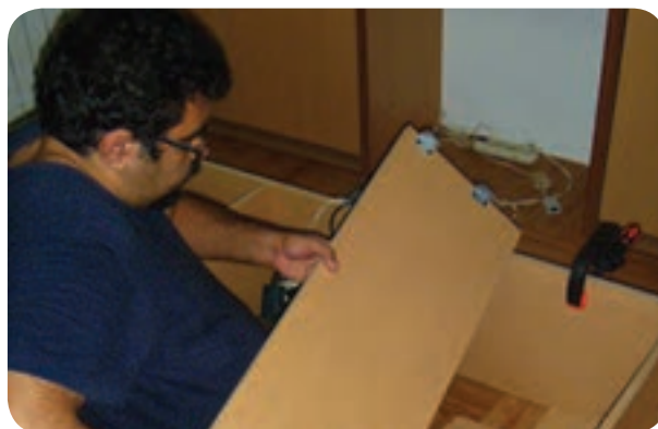
شکل ۵-۱۶۱- نصب طبقات به وسیله گونیاها فلزی
