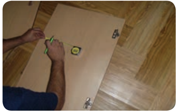
شکل ۱۵۰-۵- نصب لولای در کمد
