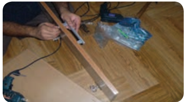
شکل ۱۵۹-۵- نصب دستگیره در کمد
