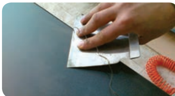
شکل ۴-۲۵ - نحوه برطرف کردن اضافه نوار با لیسه
