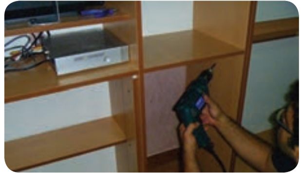
شکل ۱۷۲-۵ نصب صفحه میز آرایش
