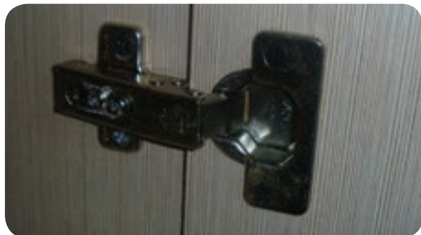
شکل ۵-۱۶۳- نصب لولای گازی فنردار به در کمد
