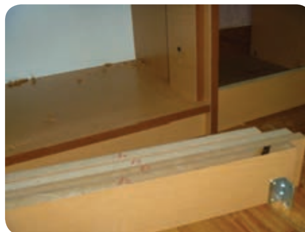
شکل ۵-۱۶۶- نصب پاسنگ با استفاده از گونیای فلزی
