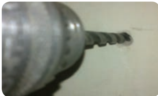
شکل ۶-۶ - سوراخکاری دیوار با مته الماسه مناسب
