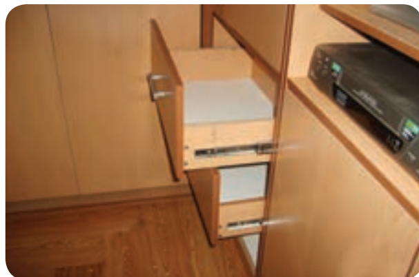
شکل ۵-۱۷۷- نصب کشویی تلسکوپی سه ریله برای کشو
