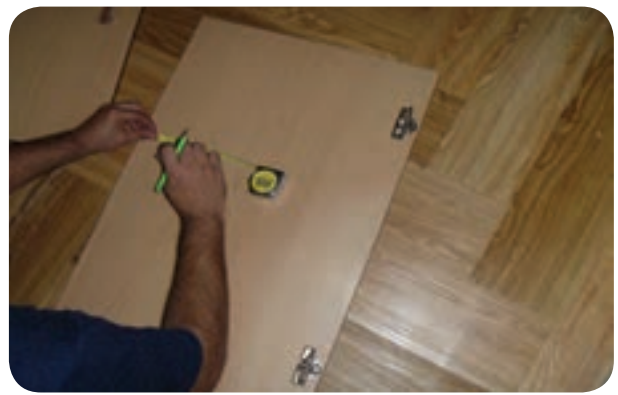
شکل ۱۵۰-۵- نصب لولای در کمد
