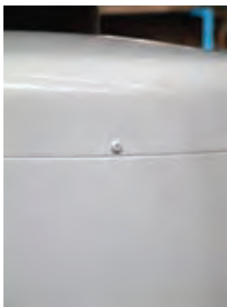
شکل ۱-۳- عدسی روپوش آب گرمکن مخزنی
