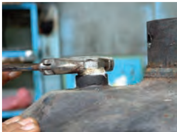
شکل ۱-۲۴- نحوه‌ی بازکردن میله‌ی منیزیم از محل خود
