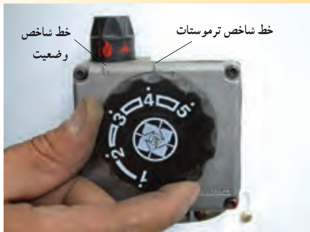
شکل ۱-۱۱۰- تغییر کلید تنظیم دما (ترموستات)
