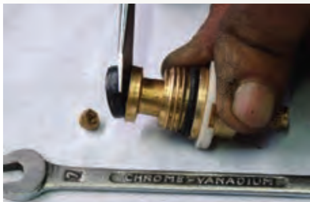
شکل ۲-۶۳- تعویض واشر
