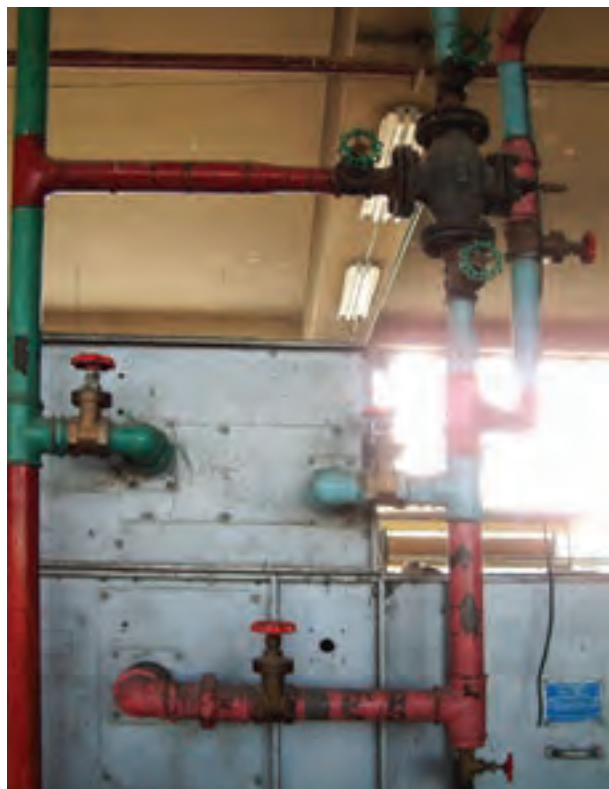
شکل ۲-۸۳ – مورد استفاده‌ی شیر فلکه در تهویه‌ی مطبوع
