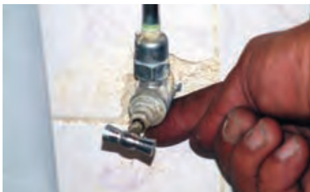
شکل ۱۴۷-۲- کنترل نشت آب از محل اتصال
