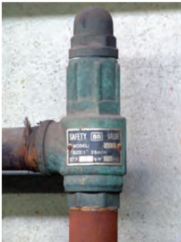
شکل ۲-۱۰۶ شیر اطمینان حساس در برابر فشار
