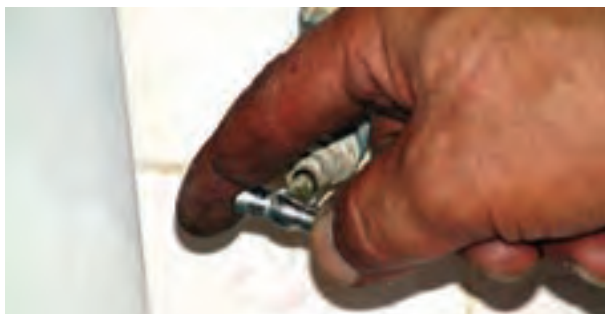
شکل ۱۴۶-۲- عمل هواگیری
