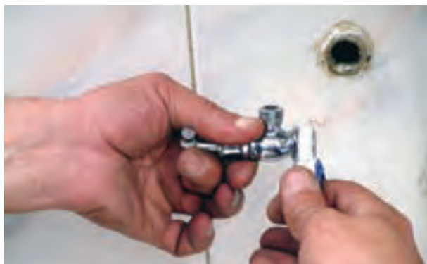
شکل ۱۴۲-۲ پیچیدن نوار تفلون به دنده‌ی \frac{1}{4} شیر پیسوار
