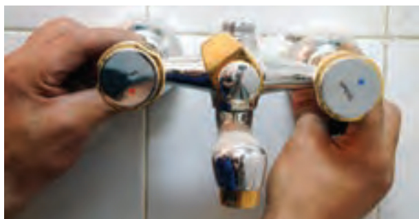
شکل ۲-۲۰۵- بستن مهره‌های شیر مخلوط دوش با دست
