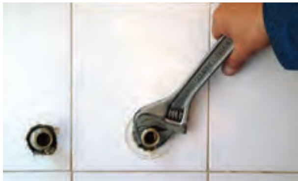
شکل ۲-۲۰۱- سفت کردن دنباله‌ها با آچار
