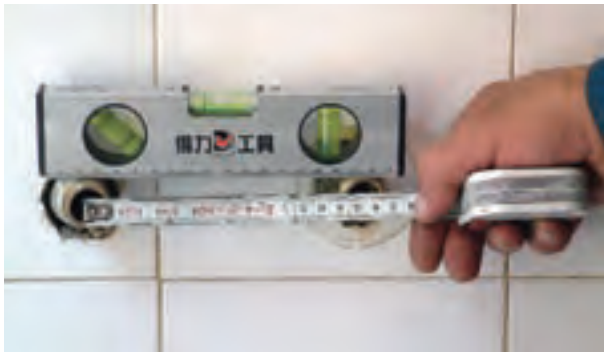
شکل ۲-۱۸۶- کنترل صاف بودن و اندازه‌ی دنباله‌ها
