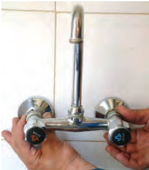
شکل ۱۷۲-۲- پیچیدن مهره‌ها به دنباله‌های شیر مخلوط
