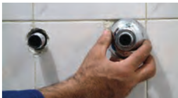
شکل ۲-۲۰۴- پیچیدن کاسه‌ها به دنباله‌ها
