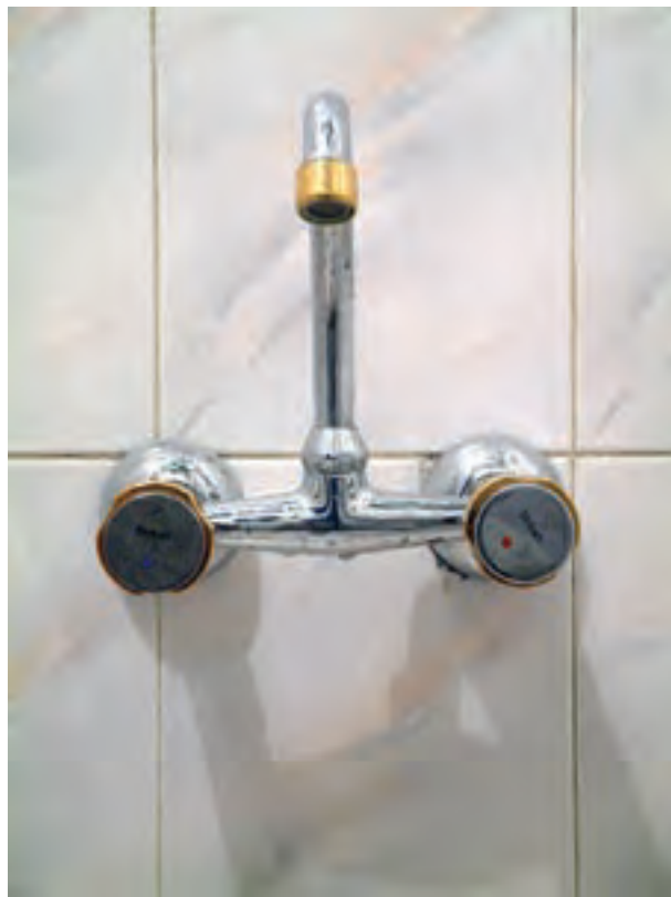
نصب شیر مخلوط دیواری
