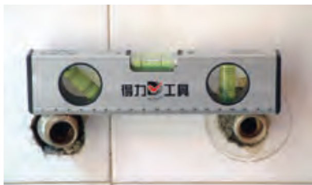
شکل ۲-۲۰۳- کنترل تراز بودن دنباله‌ها
