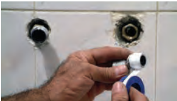
شکل ۱۸۳-۲- بیچیدن نوار تفلون به دنباله‌ها
