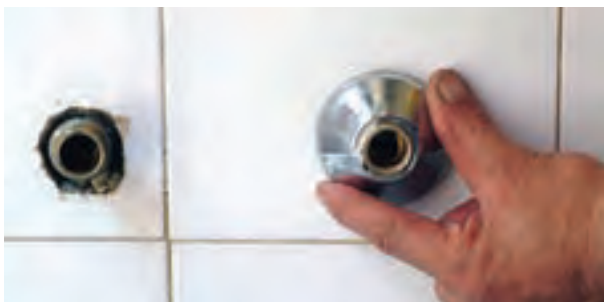
شکل ۲-۱۸۷- اتصال کاسه‌ها به دنباله‌ها
