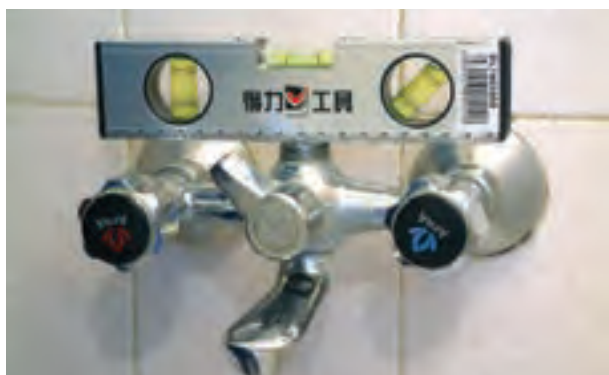
شکل ۲-۲۰۷- سنجش تراز بودن شیر مخلوط دوش
