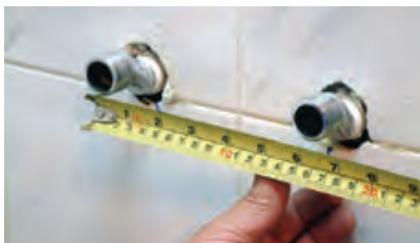
شکل ۱۶۸-۲ کنترل اندازه‌ی محور تا محور دنباله‌ها
