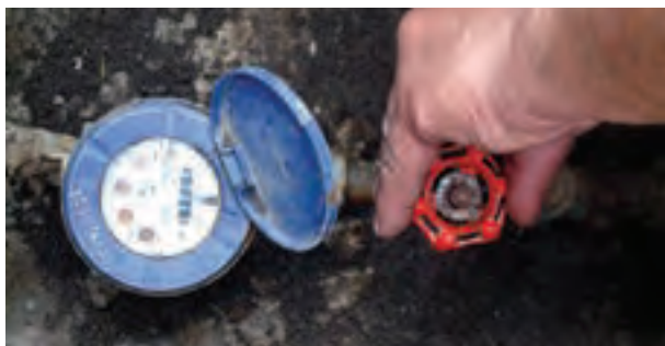
شکل ۱۹۵-۲- باز کردن شیرفلکه‌ی اصلی
