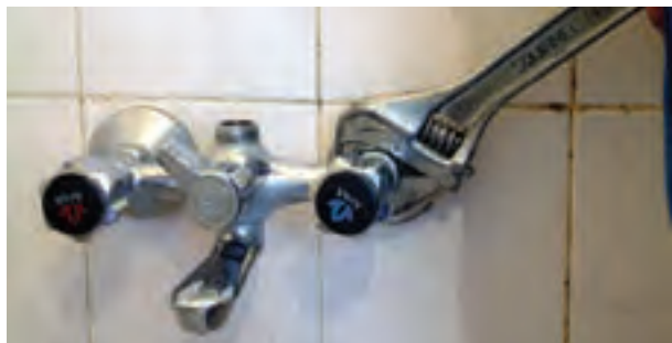
شکل ۲-۲۰۶- سفت کردن مهره‌های شیر با آچار
