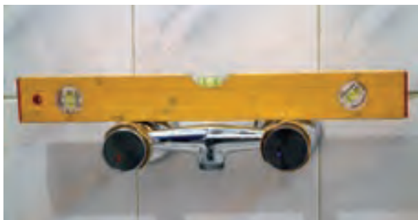
شکل ۱۹۰-۲- سنجش تراز بودن شیر مخلوط
