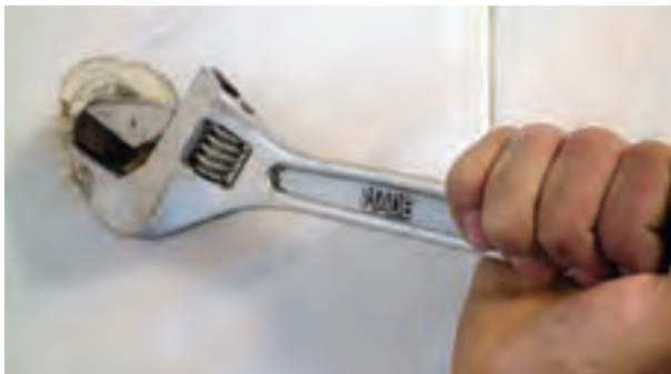
شکل ۱۸۲-۲- بازکردن درپوش‌ها
