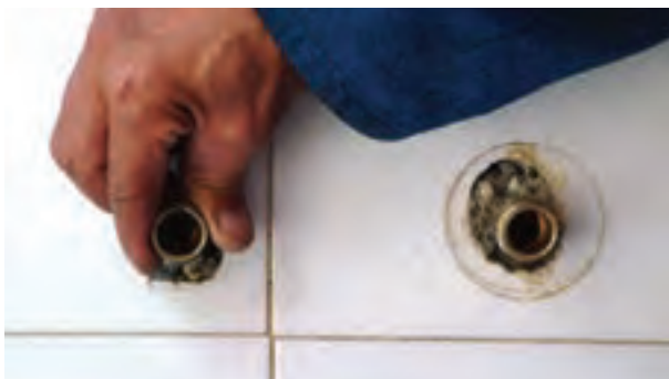
شکل ۱۸۴-۲- بیچیدن دنباله‌ها به محل نصب شیر
