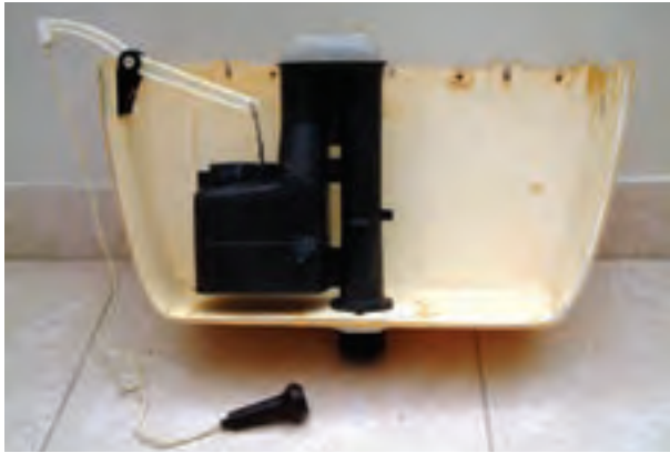
شکل ۳-۲۰۷- نصب پمپ تخلیه درون مخزن فشار
