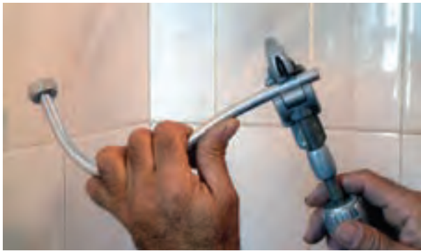
شکل ۲۲۲-۳- بریدن لوله‌ی پیسوار به وسیله‌ی لوله‌بر
