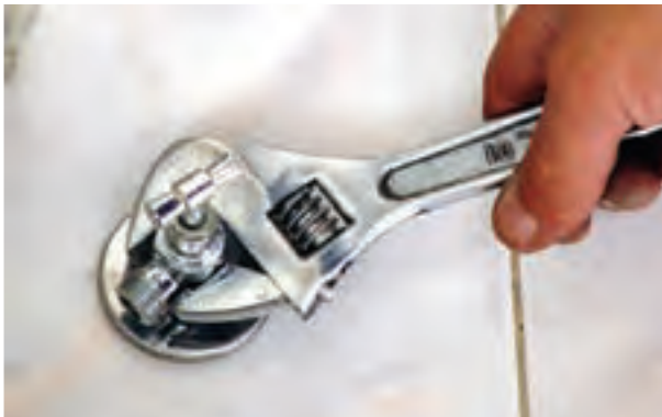
شکل ۲۲۰-۳ سفت کردن شیر پیسوار با آچار فرانسه
