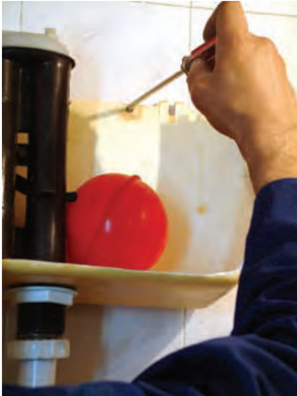
شکل ۲۱۳-۳- نصب مخزن فشاری به دیوار
