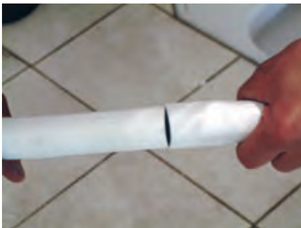
شکل ۳-۲۰۶- جا زدن لوله‌های تخلیه در درون یکدیگر
