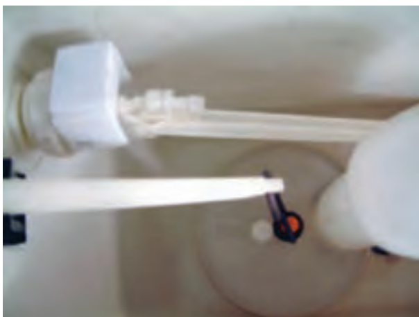
شکل ۲۲۴-۳- بر شدن مخزن فشاری
