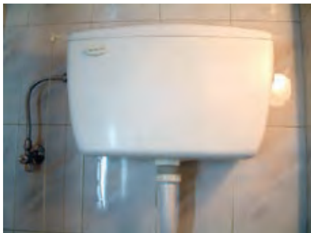
نصب مخزن فشاری
