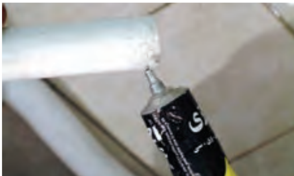
شکل ۳-۲۰۵- زدن چسب به لوله‌های تخلیه
