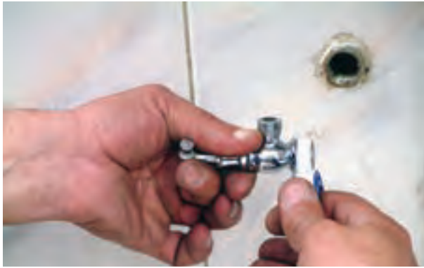
شکل ۲۱۹-۳ پیچیدن نوار تفلون به دندهی \frac{1}{4} شیر پیسوار
