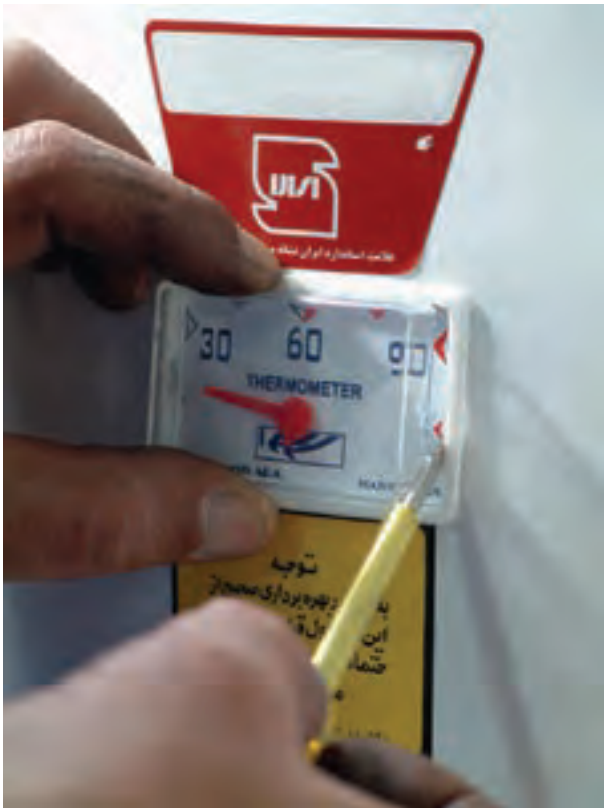
شکل ۱-۱۱۶- جدا کردن ترمومتر
