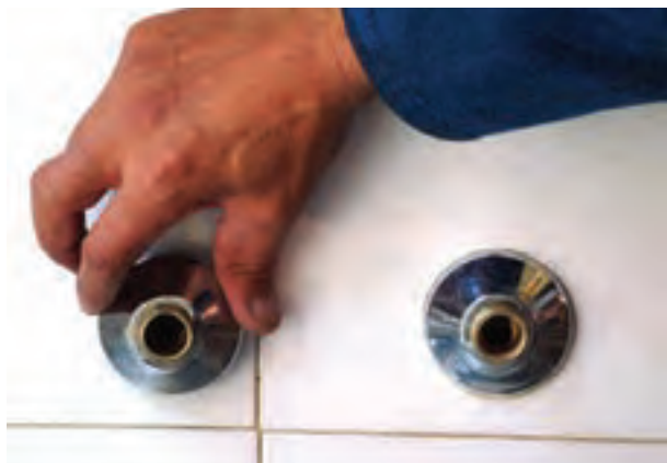
شکل ۲-۱۷۰- بستن کاسه‌ها به دنباله‌ها با دست
