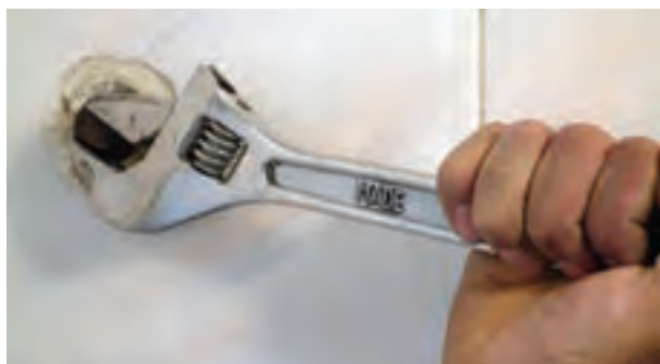
شکل ۱۹۸-۲- باز کردن درپوش‌ها
