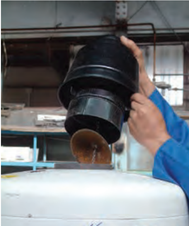
شکل ۱-۱۱۵- برداشتن کلاهک تعدیل از روی دودکش
