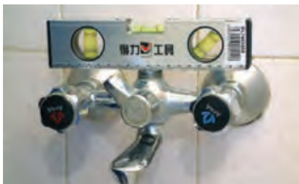
شکل ۲-۲۰۷- سنجش تراز بودن شیر مخلوط دوش
