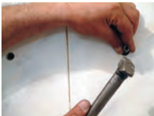
شکل ۳-۴۲ کوبیدن رولپلاک‌ها در درون سوراخ‌ها
