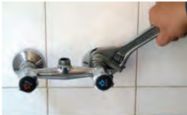
شکل ۱۷۳-۲ سفت کردن مهره‌ها به وسیله‌ی آچارفرانسه
