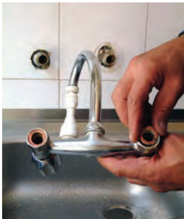
شکل ۲-۱۷۱- قراردادن واشر درون مهره‌ی تنه شیرمخلوط
