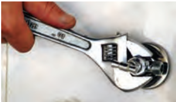
شکل ۱۴۴-۲- سفت کردن شیر پیسوار با آچار فرانسه
