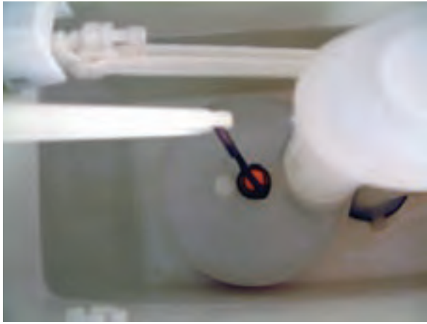
الف - بر شدن مخزن فشاری و قطع کردن شیر شناور
