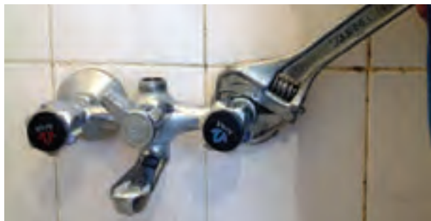
شکل ۲-۲۰۶- سفت کردن مهره‌های شیر با آچار
