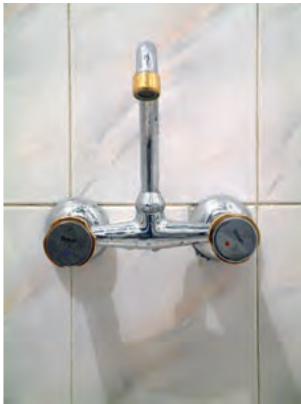
نصب شیر مخلوط دیواری
