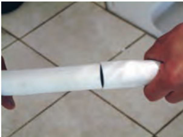
شکل ۳-۲۰۶- جا زدن لوله‌های تخلیه در درون یکدیگر
