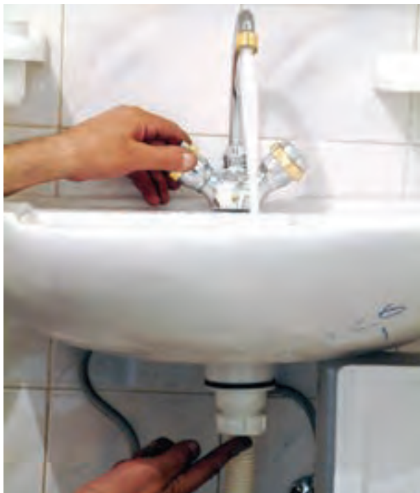
شکل ۳-۵۷- عمل کنترل نشت آب از محل‌های اتصال
