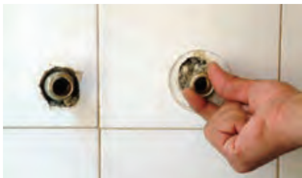
شکل ۲۰۰-۲- بستن دنباله‌ها با دست
