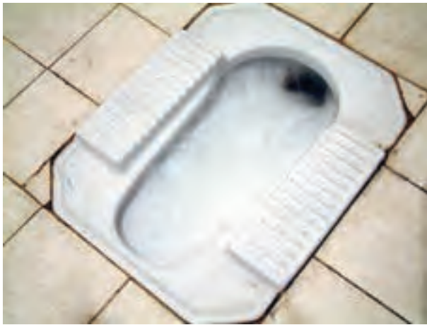
ب - عمل تخلیه شدن آب درون مخزن فشاری به درون کاسه توالت
