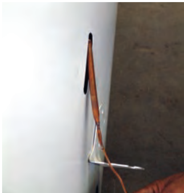
شکل ۵۶-۱- الف - قرار دادن بالب ترموستات در محل خود
