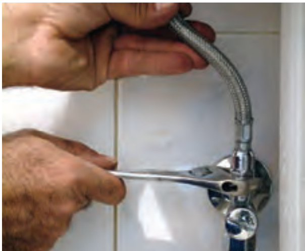
شکل ۳-۴۹ سفت کردن مهره‌های شیلنگ به شیر پیسوار
