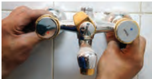
شکل ۲-۲۰۵- بستن مهره‌های شیر مخلوط دوش با دست
