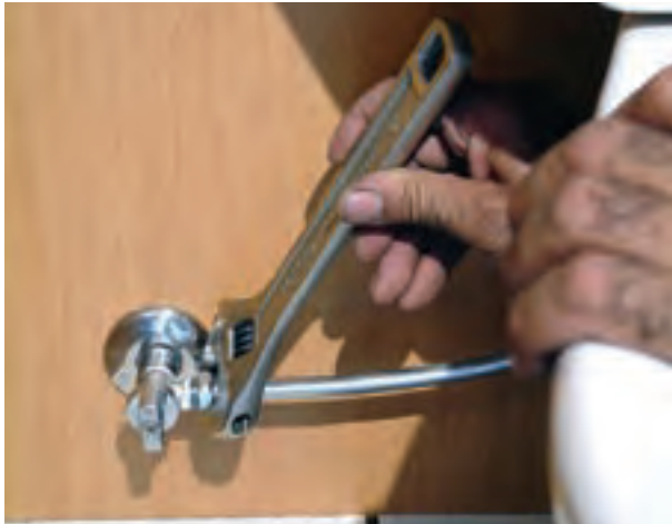
شکل ۳-۲۵۶- سفت کردن مهره‌ی شیر پیسوار
