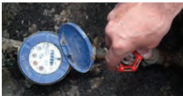
شکل ۱۴۰-۲ بستن شیر فلکه‌ی اصلی
