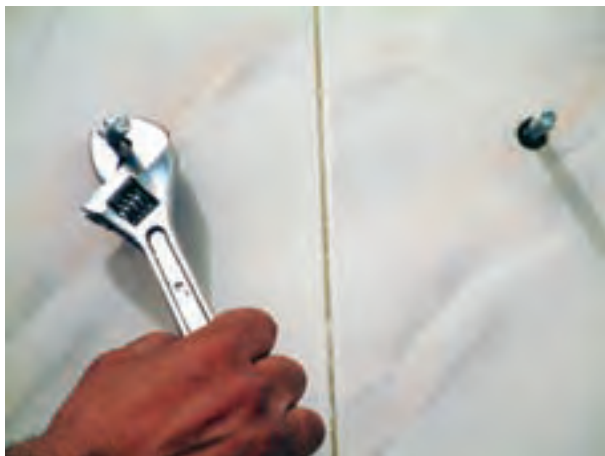
شکل ۳-۴۴- سفت کردن پیچ‌ها در درون رولپلاک‌ها
