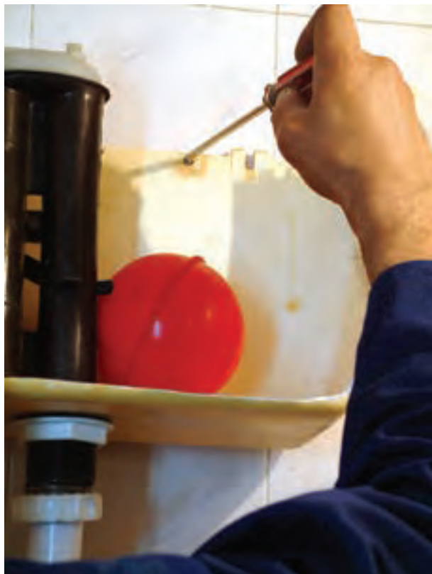
شکل ۲۱۳-۳- نصب مخزن فشاری به دیوار
