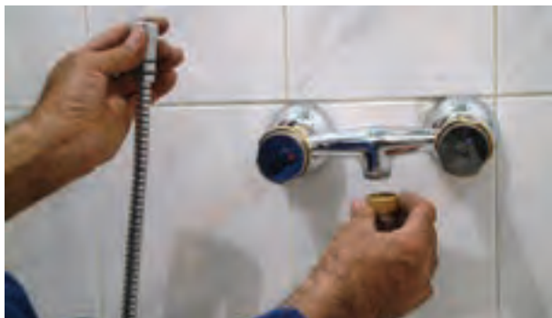
شکل ۱۹۱-۲- اتصال شیلنگ آفتابه به شیر مخلوط توالت
