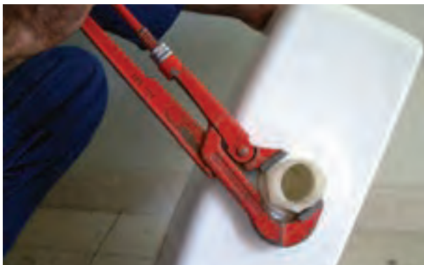
شکل ۳-۲۰۸- سفت کردن مهره‌ی پمپ تخلیه
