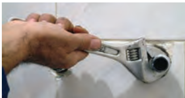
شکل ۱۶۷-۲ سفت کردن دنباله‌ها با آچار فرانسه
