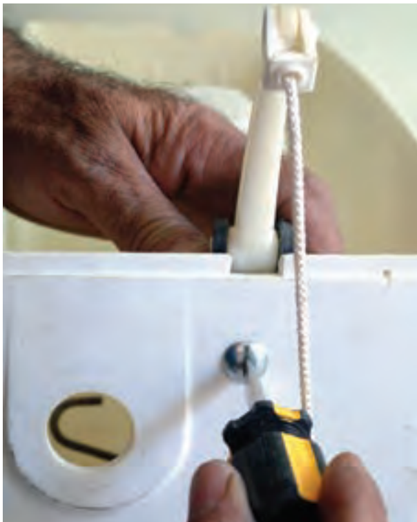
شکل ۳-۲۰۹- اتصال اهرم به بدنه‌ی مخزن فشاری
