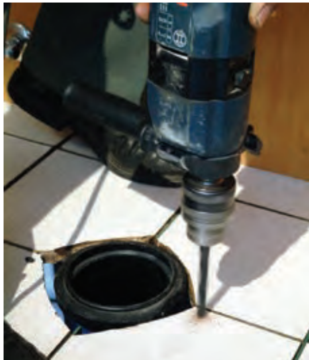
شکل ۲۴۶-۳- سوراخ‌کاری محل‌های علامت‌گذاری شده
