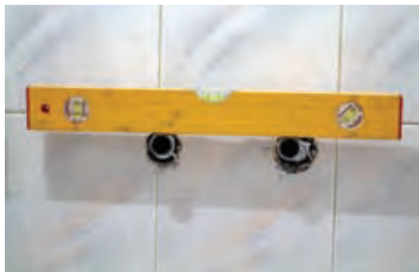
شکل ۲-۱۶۹- کنترل صاف بودن دنباله‌ها
