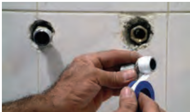
شکل ۱۹۹-۲- پیچیدن نوار تفلون به دور دنده‌ی ۱/۴ دنباله‌ی شیر مخلوط
