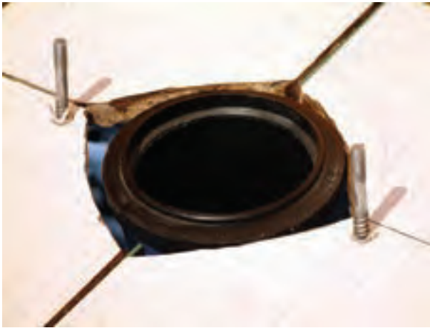
شکل ۳-۲۴۷- بستن پیچ‌های روکا در داخل رولپلاک‌ها
