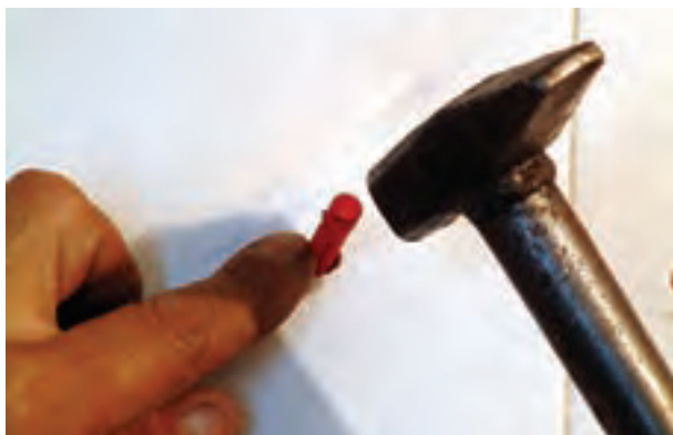
شکل ۱۹۳-۲- کوبیدن رولپلاک درون سوراخ
