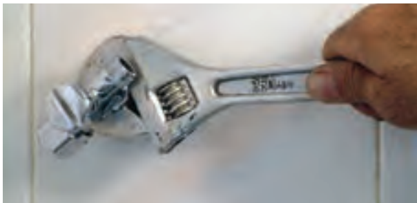
شکل ۳-۴۸ سفت کردن شیر پیسوار با آچار فرانسه
