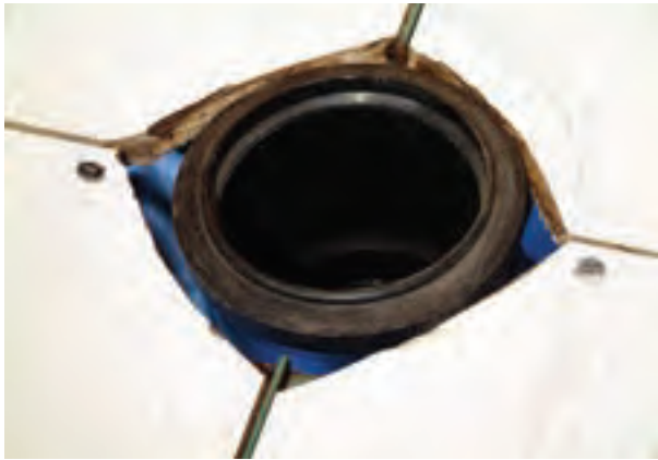
شکل ۲۴۴-۳- قرار دادن بوگیر در داخل زانویی
