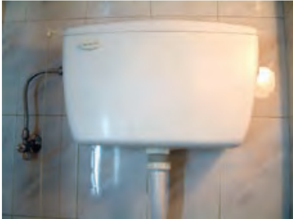
نصب مخزن فشاری
