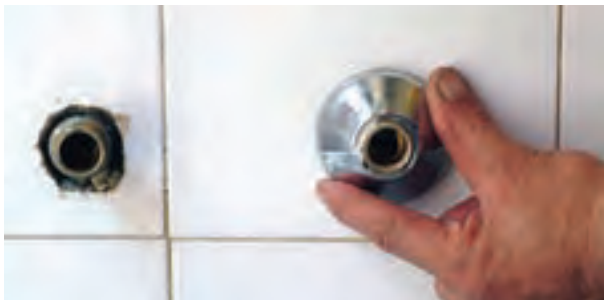
شکل ۲-۱۸۷- اتصال کاسه‌ها به دنباله‌ها
