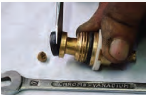
شکل ۲-۶۳- تعویض واشر
