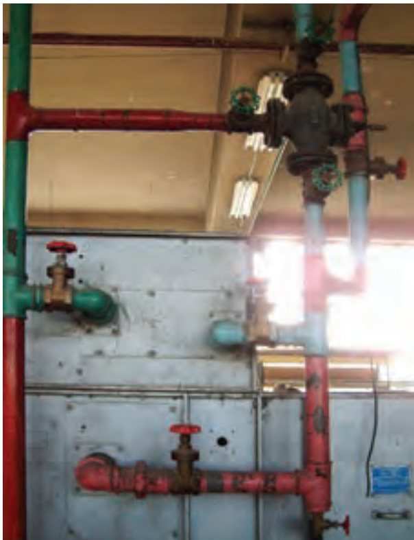
شکل ۲-۸۳ – مورد استفاده‌ی شیر فلکه در تهویه‌ی مطبوع
