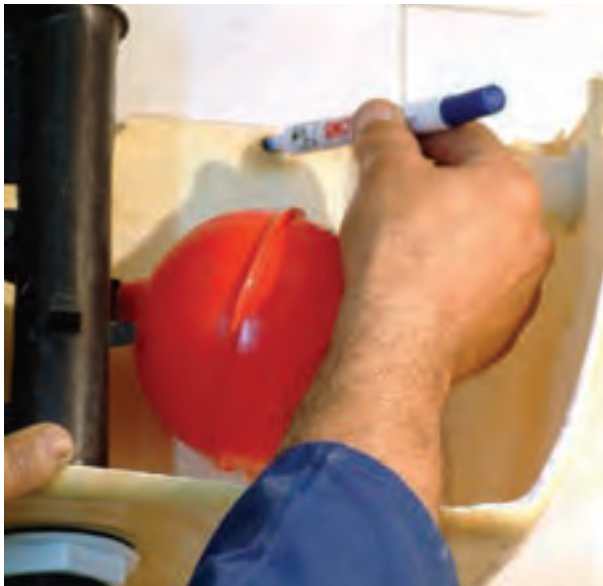
شکل ۲۱۱-۳ قراردادن مخزن فشاری بر روی لوله‌ی تخلیه و علامت‌گذاری محل‌های اتصال مخزن به دیوار
