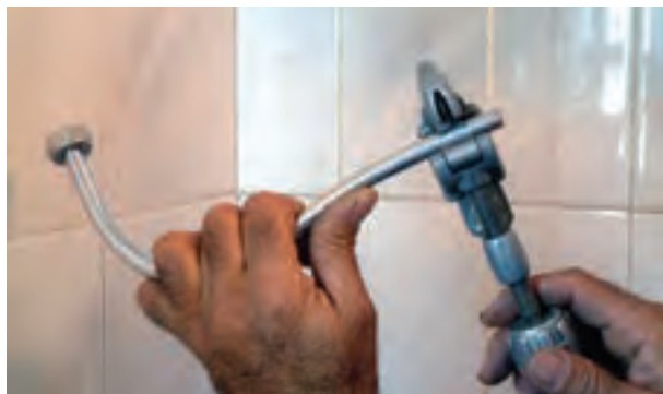
شکل ۲۲۲-۳- بریدن لوله‌ی پیسوار به وسیله‌ی لوله‌بر
