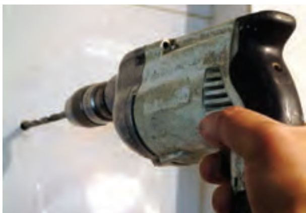
شکل ۱۹۲-۲- سوراخ کردن محل نصب بست آویز
