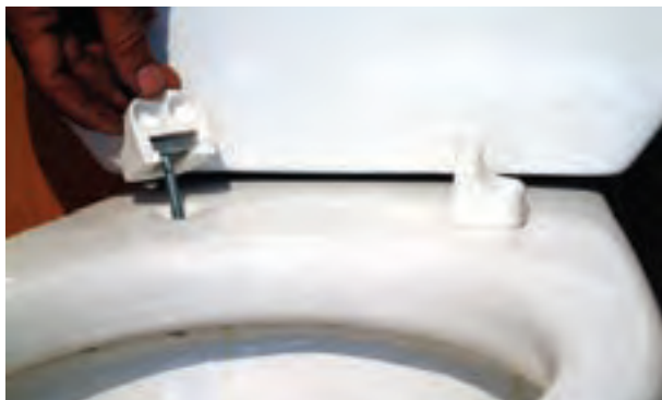
شکل ۳-۲۵۳- اتصال بست‌های نگهدارنده به توالت فرنگی
