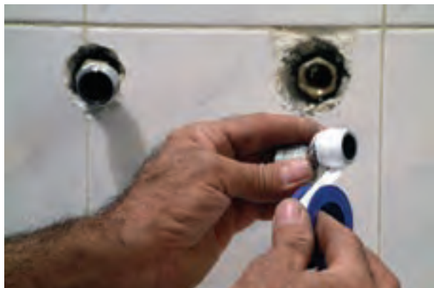
شکل ۱۶۵-۲ پیچیدن نوار تفلون به دنده‌ی \frac{1}{4} دنباله‌ی شیر
