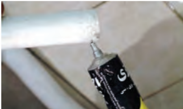
شکل ۳-۲۰۵- زدن چسب به لوله‌های تخلیه
