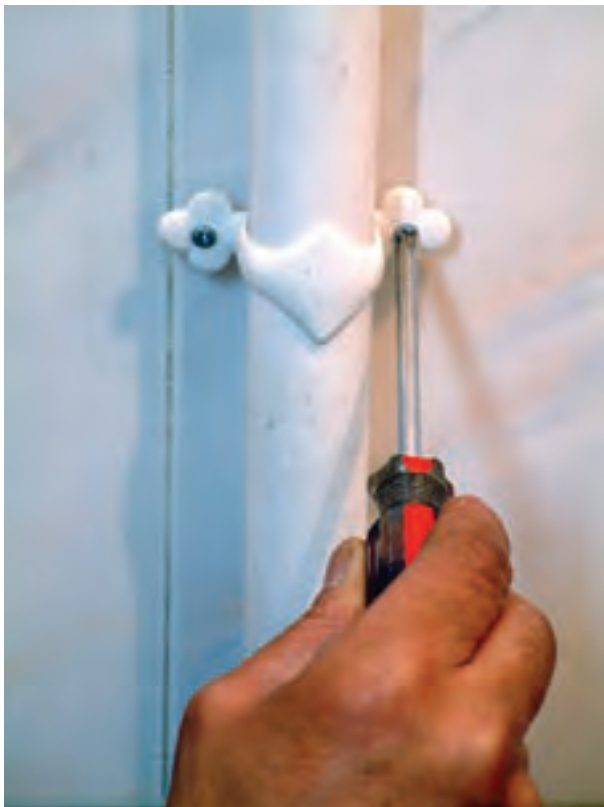
شکل ۲۱۸-۳- نصب بست دو طرفه بر روی لوله ی تخلیه
