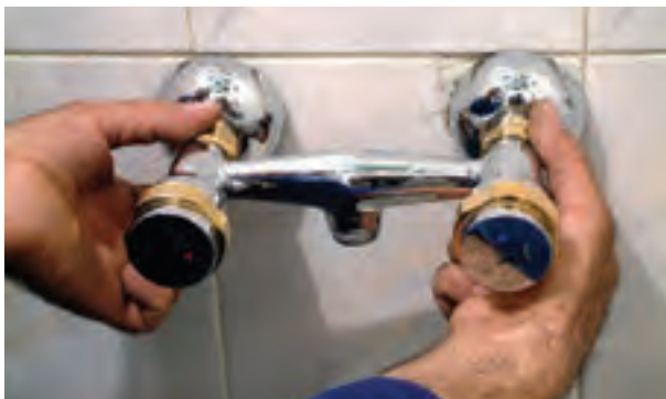
شکل ۲-۱۸۸- اتصال شیر مخلوط توالت به دنباله‌ها
