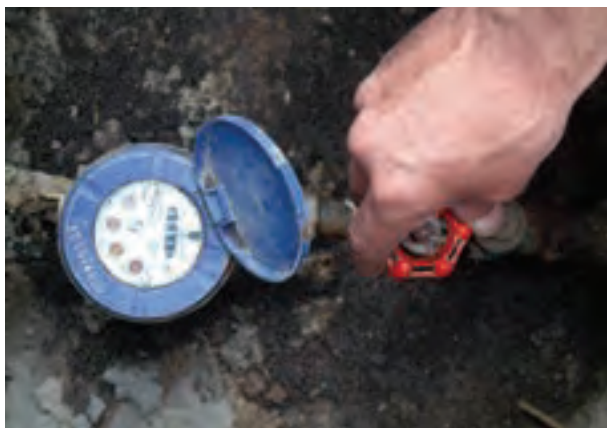
شکل ۲-۶۰- بستن شیر فلکه‌ی اصلی آب ساختمان
