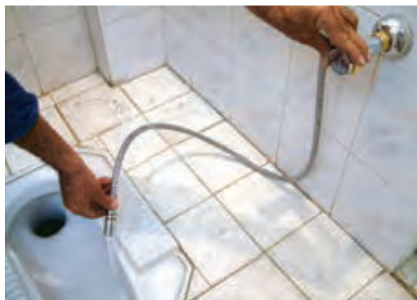
شکل ۱۹۶-۲- عمل هواگیری شیرمخلوط توالت
