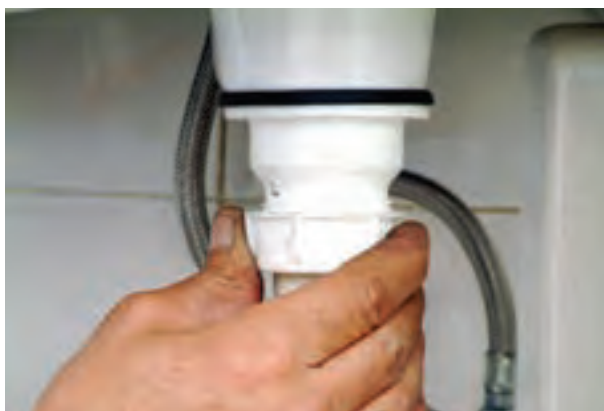
شکل ۳-۵۶- بستن مهره‌ی لوله‌ی عمودی سیفون به زیراب
