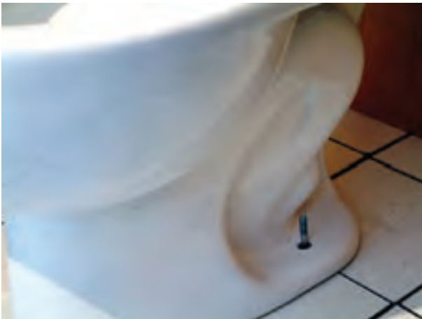
شکل ۳-۲۴۸- قرار دادن توالت فرنگی در محل خود
