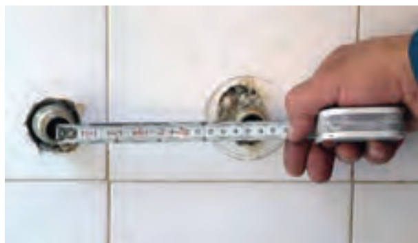
شکل ۲-۲۰۲- کنترل نمودن فاصله‌ی دنباله‌ها به وسیله‌ی متر
