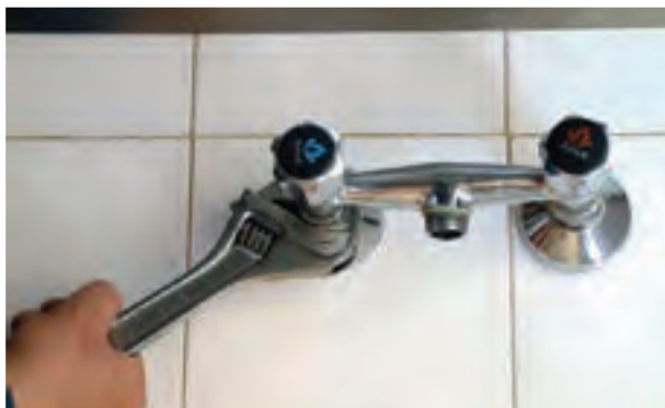
شکل ۱۸۹-۲- سفت کردن مهره‌ها با آچار فرانسه
