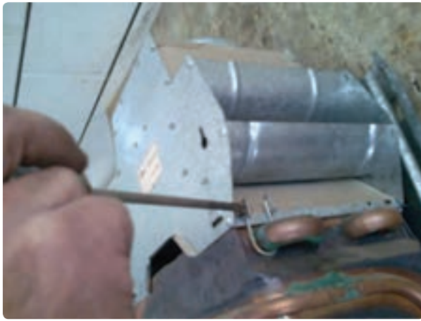
شکل ۶-۱- جدا کردن کلاهک تعدیل از مبدل
