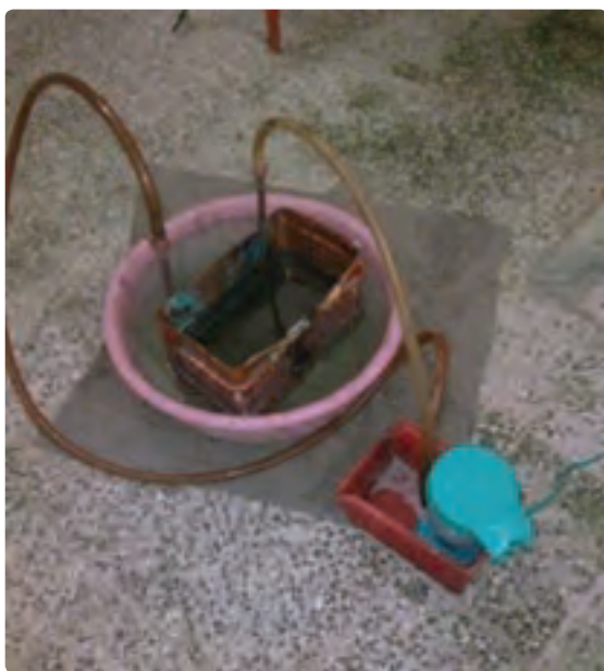
شکل ۱۹-۵- رسوب‌زدایی با پمپ
