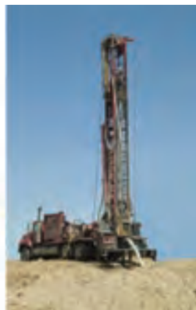
دکل حفاری چاه آب
