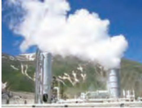
شکل ۷-۱- نیروگاه زمین گرمایی مشکین شهر - اردبیل
